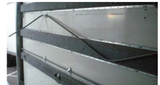
Tapizados y varillas: Varillas, elementos de fijación, faltan los tapizados o se han deformado y no merece la pena repararlos
