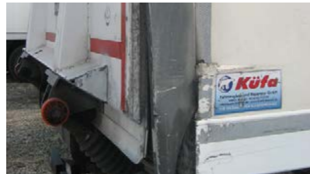
Puertas laterales y traseras: Importante deformación: Tiempo de reparación > 1 h no merece la pena de reparar, el cierre no es estanco
