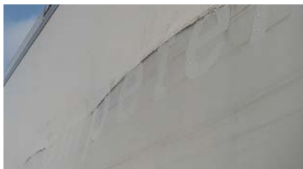
Panel lateral de fibra: Deformación en la parte inferior, longitud > 1 m Nota: La sustitución del panel frontal de la carrocería inferior requiere el desmontaje de los bajos de la carrocería.
