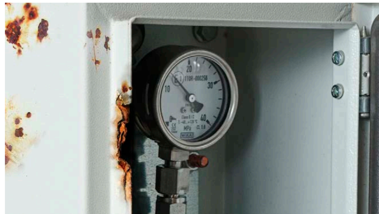
No está la llave del cárter de protección, receptáculo del GNC o manómetro dañados → cobro por sustitución del cárter completo.
