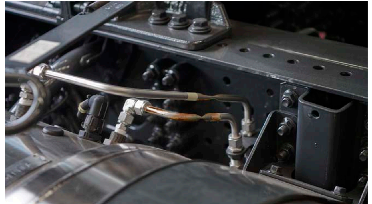
Oxidación, abolladuras, roturas y/o hendiduras → cobro por sustitución de los tubos rígidos.
