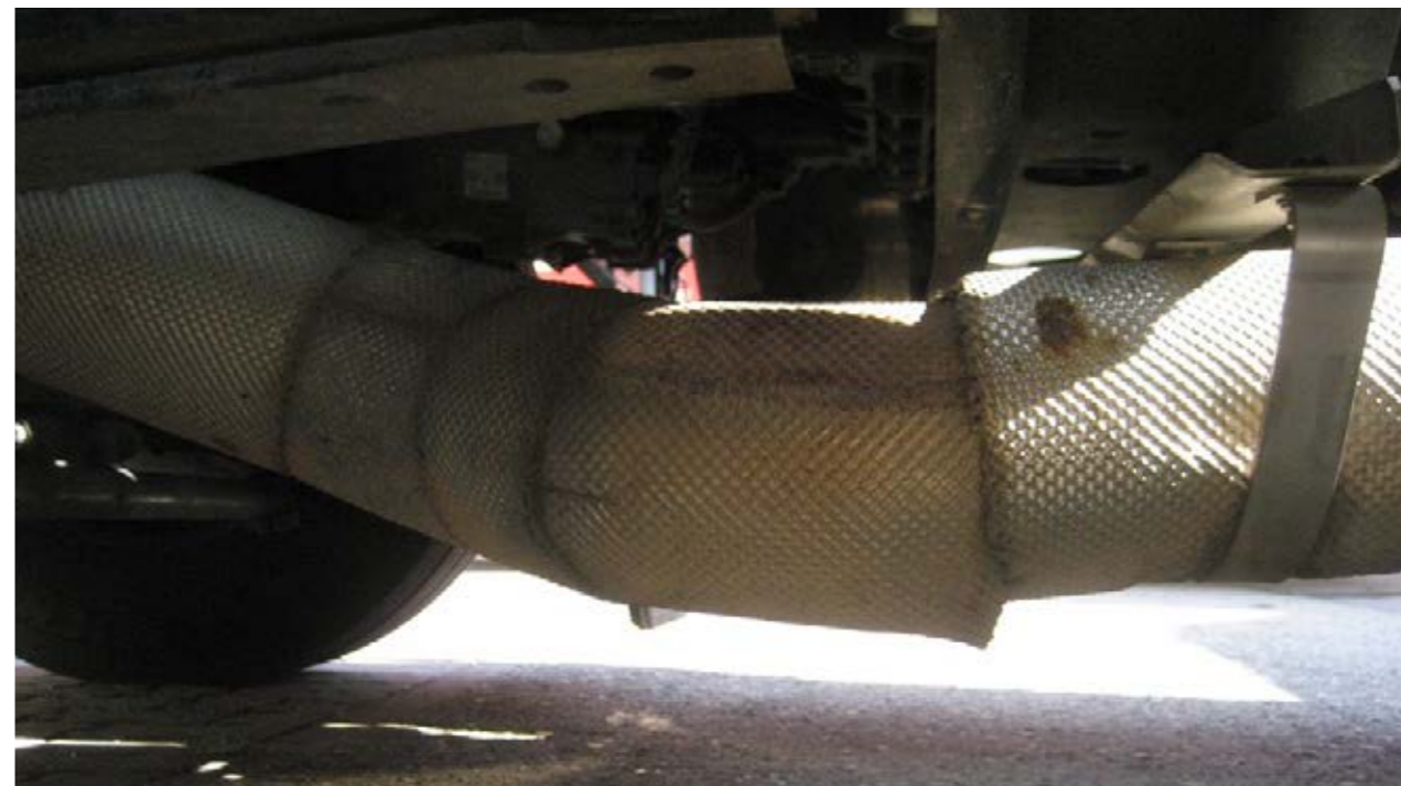
No aceptado: Daños por golpes, o mal uso
