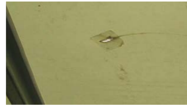
Zona del techo: Perforado o desgarrado que merece la pena de reparar
