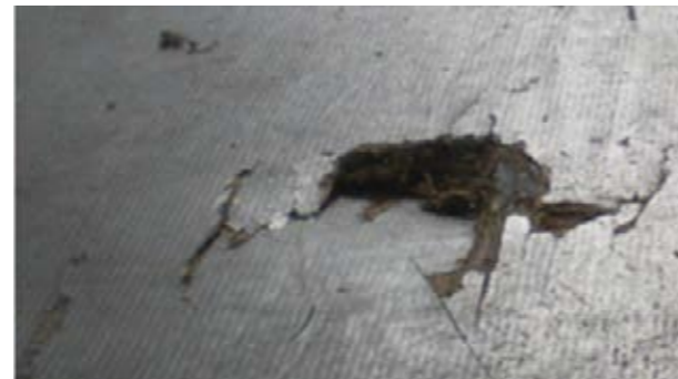
Piso: Deformaciones o perforaciones que merece la pena de reparar
