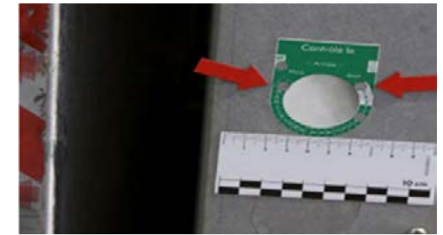
Compuerta de carga: Fechas de control vencidas
