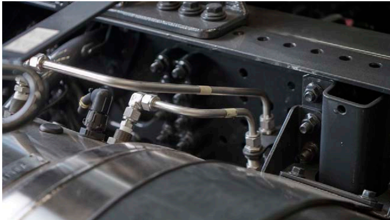
Las bombonas de GNC deben devolverse en las condiciones debidas, como se ilustra en las fotos.
